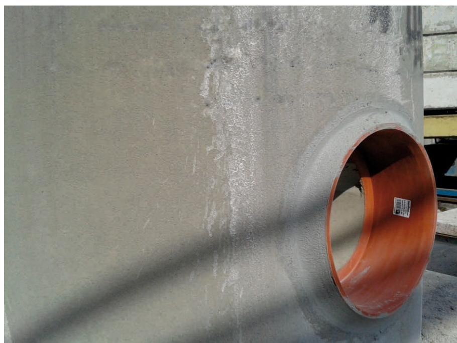
2. фиксируя подобным образом, как в случае герметичного перехода, патрубок из трубы InCor<sup>®</sup> длиной превышающей длину стены не более, чем  $0,5 \times DN$  или 0,5 м.
